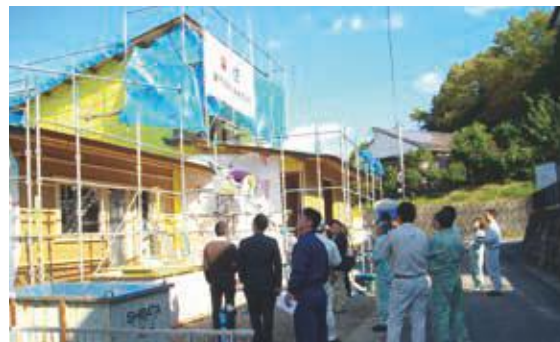
省エネ住宅の現場研修
