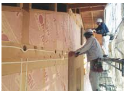
現場施工研修(断熱工事の施工手順)
