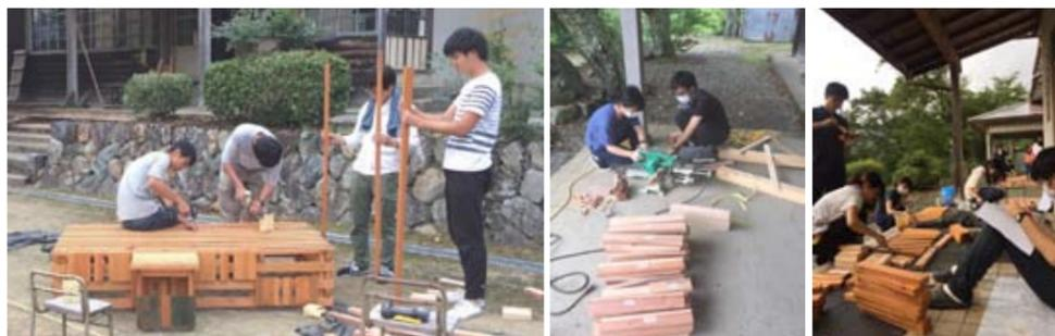
床面作製の様子 部材の切り出し 防腐塗料の塗装
